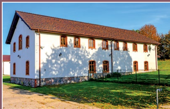
Dawny folwark w Kuźnicy Żelichowskiej Altes Vorwerk in Selchowhammer
