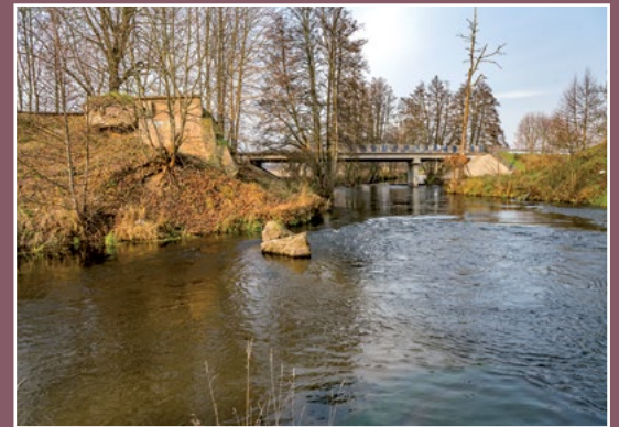
Most przez Drawę w Bielicach Nowych Draße Brücke in Neu Beelitz
