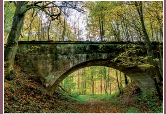
Most kolejowy w Żelichowie Eisenbahnbrücke in Selchow
