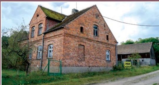
Dom w Przesiekach Haus in Prossedel
