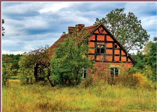
Szachulcowy dom w Łokaczu Wielkim Fachwerkhaus in Lukatz
