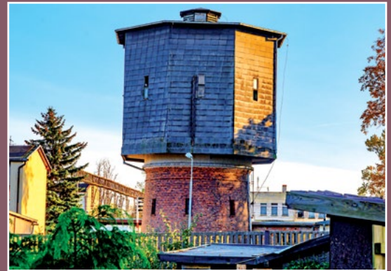
Wieża ciśnień w Krzyżu Wielkopolskim Wasserturm in Kreuz
