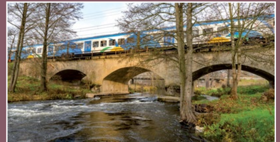
Most kolejowy przez Drawę Eisenbahnbrücke auf der Drage
